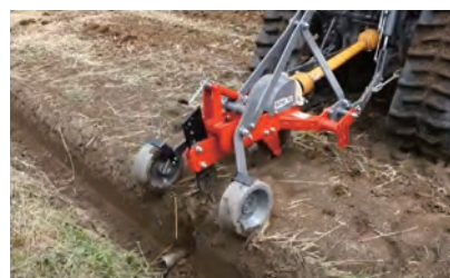
写真2＝サブソイラによる弾丸暗渠の施工
