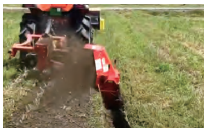
写真1＝溝堀機による明渠の施工
