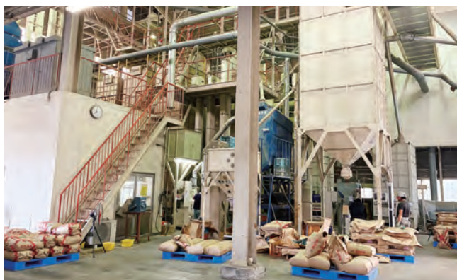
稼働するライスセンター
