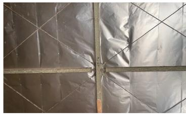
これは遮熱シート施工前後と、サーモグラフィでの比較画像です。撮影時の外気温は約38℃です。遮熱シート施工前は屋根裏面が64℃まで達しているのに対し、施工後は外気温より低い35℃になりました。
