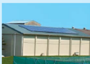
倉庫屋根に設置した太陽光発電装置
