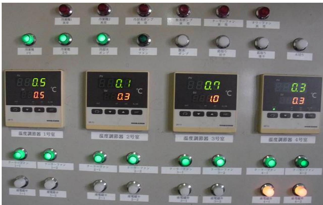
写真4. 3-4 制御装置表示パネル(上段緑の表示が庫内の現在値、下段赤の表示が設定値である)
