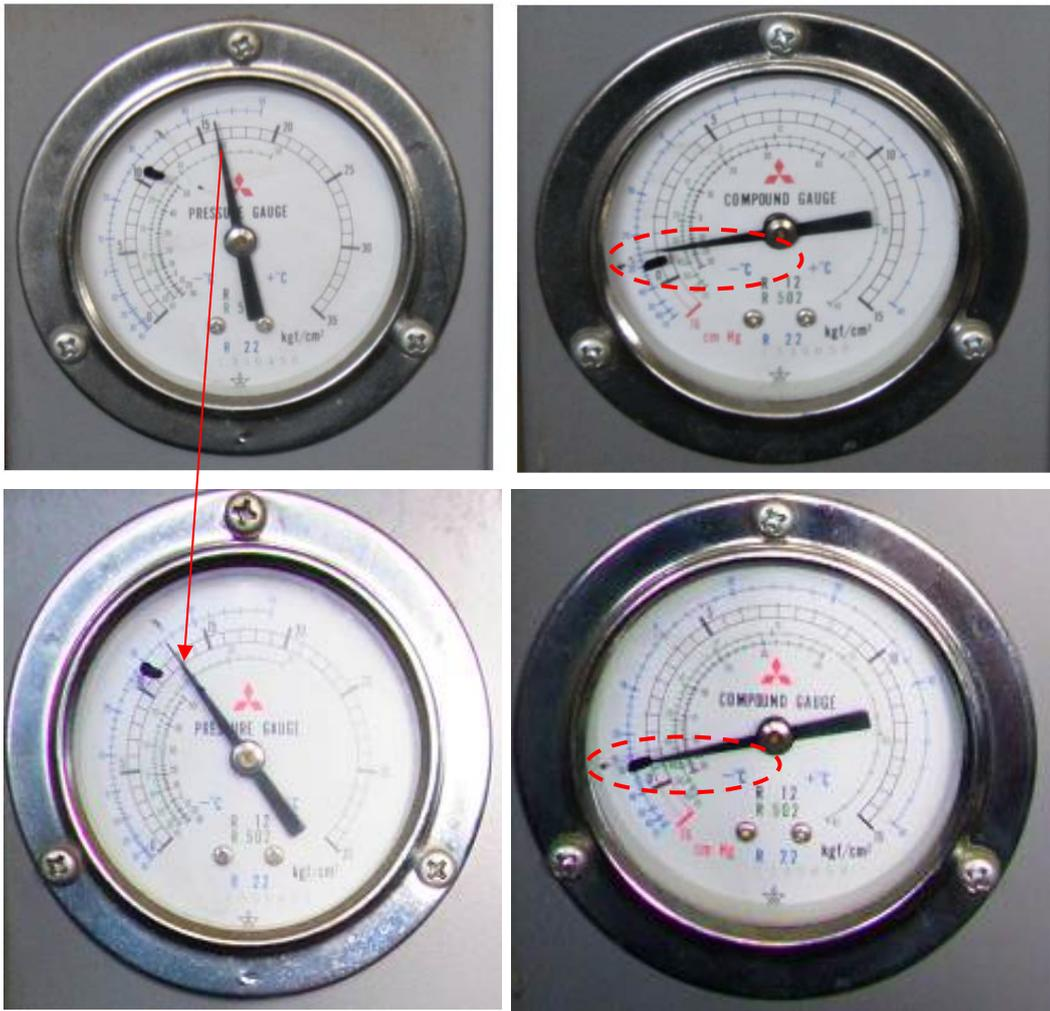
写真4.3-2 冷凍機の圧力比較(上/昨年度ピーク時、下本年度中間期)
