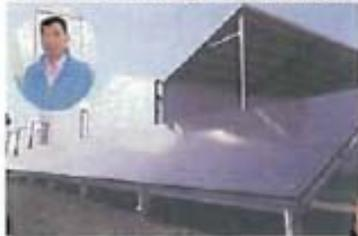
**栃木県のユリ**：宇都宮市エフ・エフ・ヒライテ 韓国のS-ENERGY社製パネルを採用。縦約1m、約横1.6mのパネルを45枚使用し、年間発電量は約1万2千kw。連棟ハウス2棟(8734平方メートル)のファンやボイラー、事務所の電気使用量とCO2排出量の2割削減
