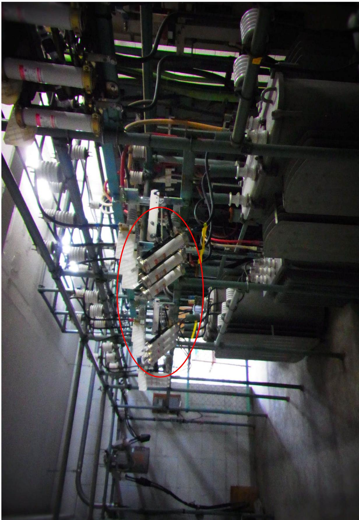
写真4.5-2 不使用時のトランス2系統解列状況
