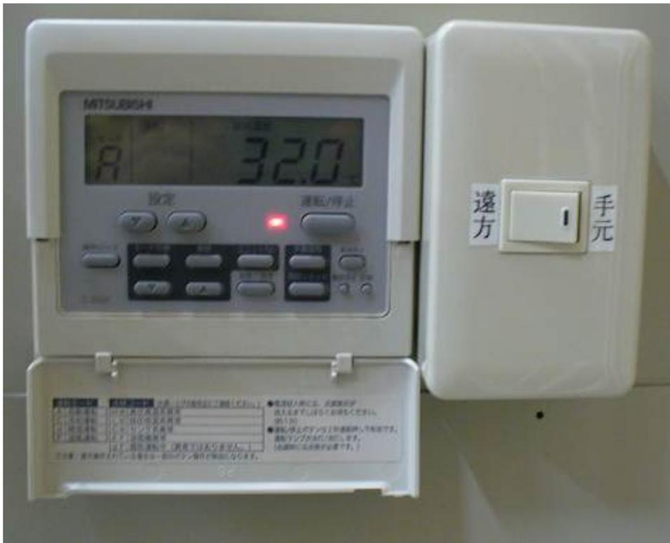
写真 4.2-9 除湿機中央・現場切替スイッチとマニュアル運転時機側設定器
