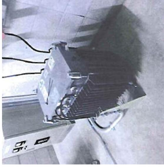
写真4.6-3 パワーコンデンショナー(上)、交流集合盤(左)、交流集系用昇圧トランス(右)
