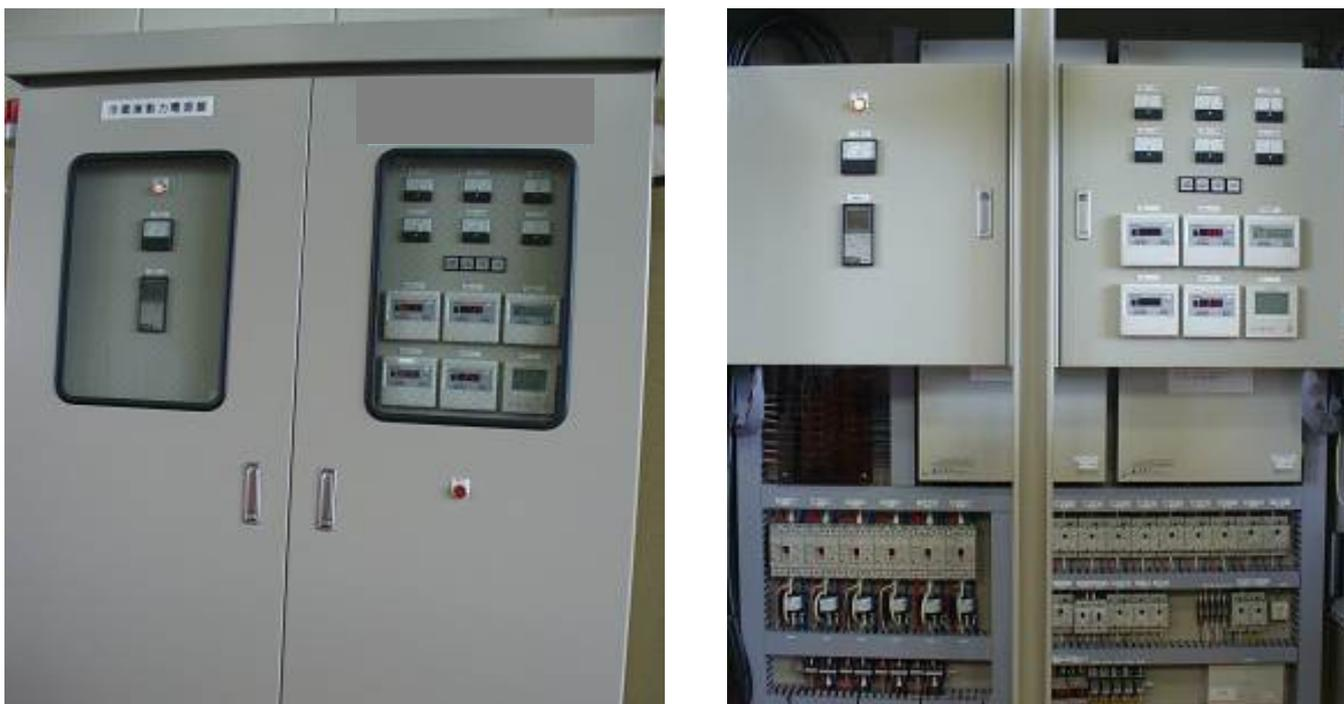
写真 4.2-5 動力制御盤の外観及び内部
