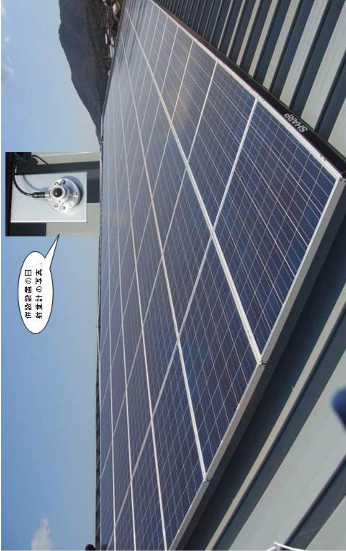
写真4.6-1 太陽光発電パネル近景と日射量計拡大写真
